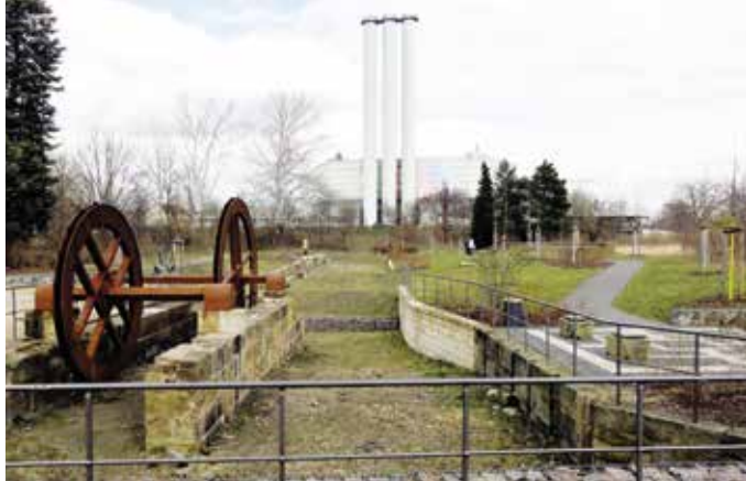
Pulvermühlenpark und Kraftwerk Nossener Brücke, Dresden. Foto: Marlies Goethe 2017
