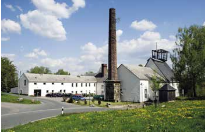
Tagesgebäude vom Einigkeiter Kunst- und Treibeschacht der Grube Alte Hoffnung Gottes Erbstolln 1 bei Freiberg. Foto: Jens Kugler 2019
